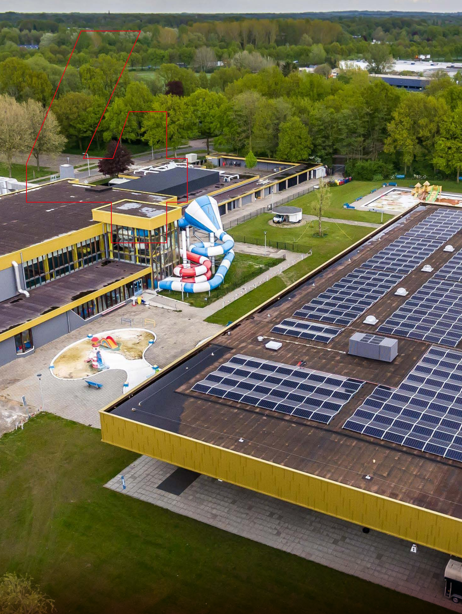
In gemeente Hengelo zijn zonnepanelen op het Twentebad geplaatst. Het Twentebad is goed op weg om aardgasvrij te worden.
